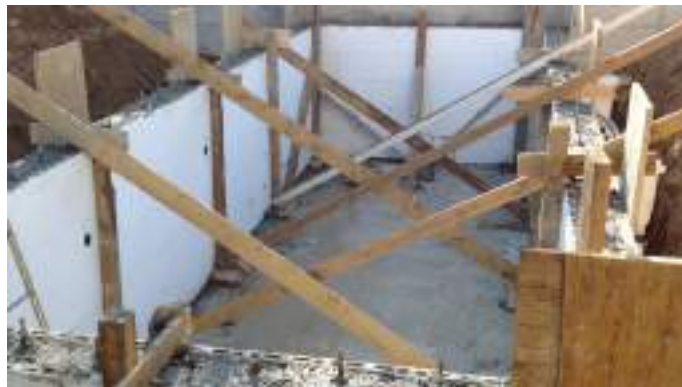
Operazione di controventatura dei casseri Blublock
