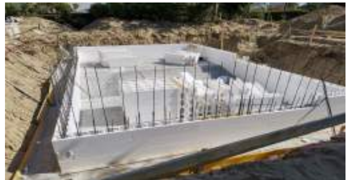
Posa della linea di corso con i casseri Blublock
