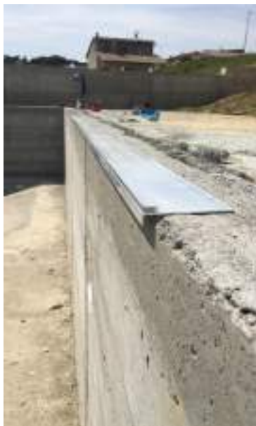
Operazione di posa e fissaggio della guida in alluminio
