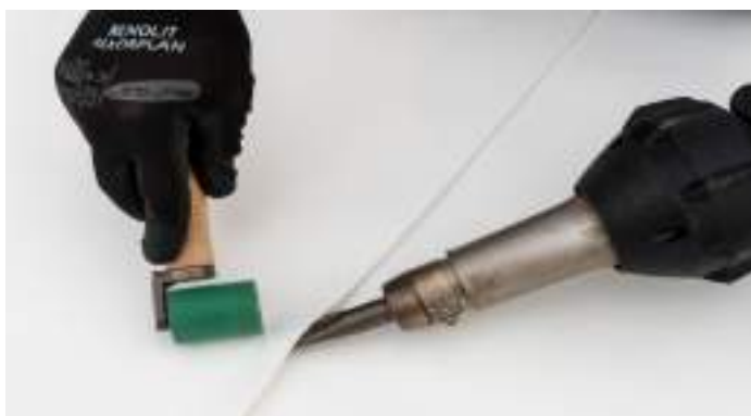
Dettaglio dell'accoppiamento del liner
