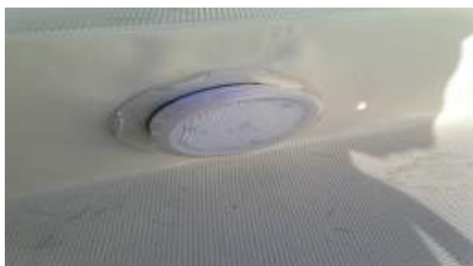
Rimozione del liner in eccesso
