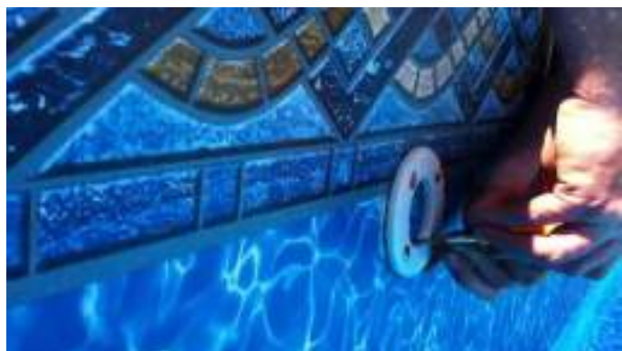
Rimozione del liner in eccesso
