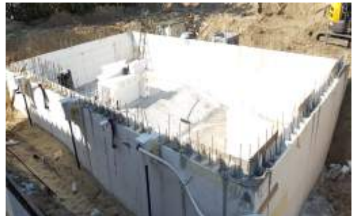
Getto di cemento completato
