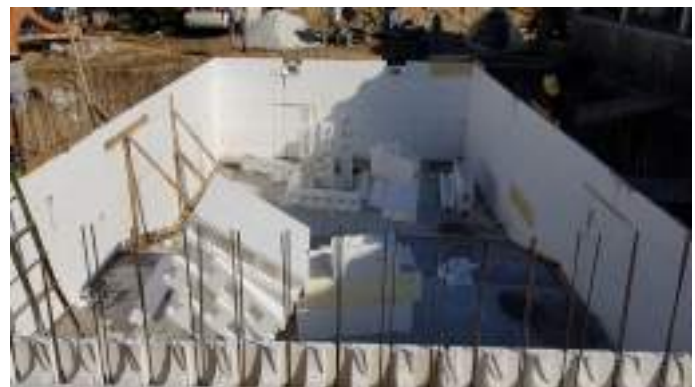
Completamento delle pareti con i casseri Blublock
